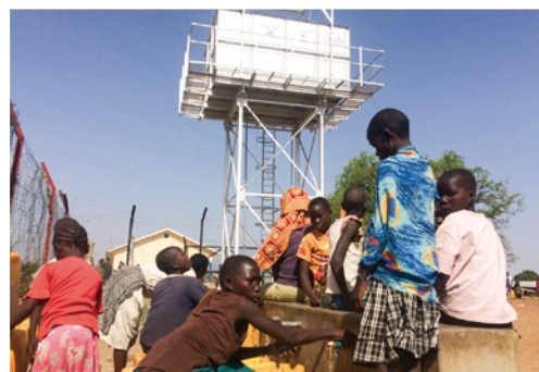
太陽光パネル式給水施設改修(ホストコミュニティ)
