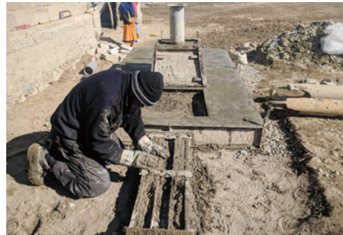
井戸の設置工事の様子
