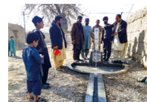
井戸が完成。水は生きるための必需品
