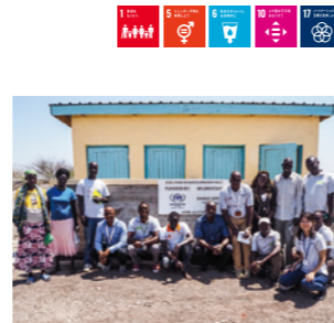
難民居住地区での学校トイレ建設(引渡式)
